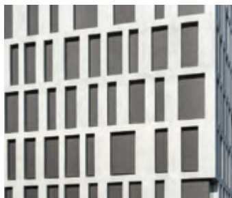
Estores de fachada
